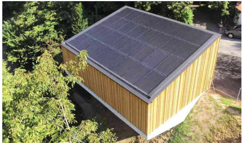
Die Demo-Garage in Rovio TI: PV-Anlage 60 m 2 mit Sunage-Photovoltaikpanelen und Montage-/Dämmsystem «Designergy». (Bilder: Simone Bossi)
